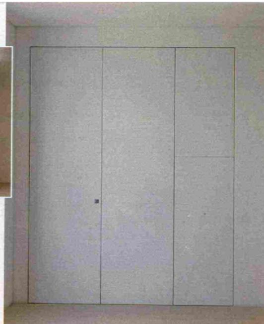
Il sistema si compone di profili in alluminio, adattabili alla muratura e al cartongesso, e di pannelli di chiusura in alluminio stratificato che possono essere forniti anche preverniciati.
